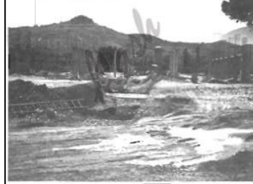
1965 - Tre aspetti dei lavori per la costruzione della Cartiera Mondadori.
